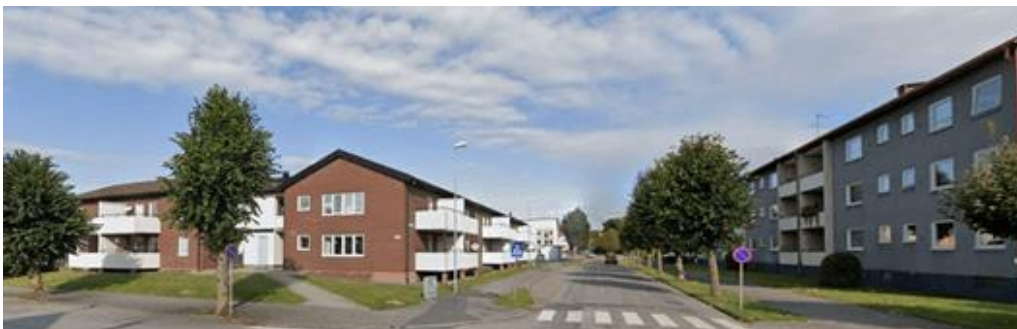
Figur 12: Bilden visar till vänster hyreshuset inom fastigheten Falken 16 sett från korsningen Norra Bollgatan/ Kyrkogatan
