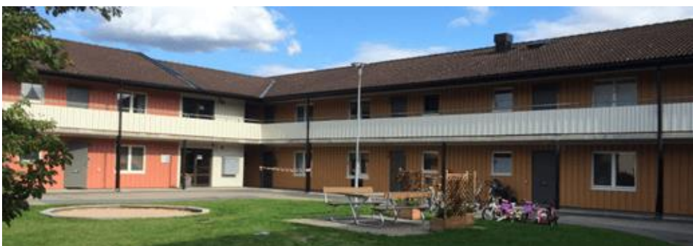
Figur 13: Bilden visar hyreshuset inom fastigheten Falken 16 sett från innegården
