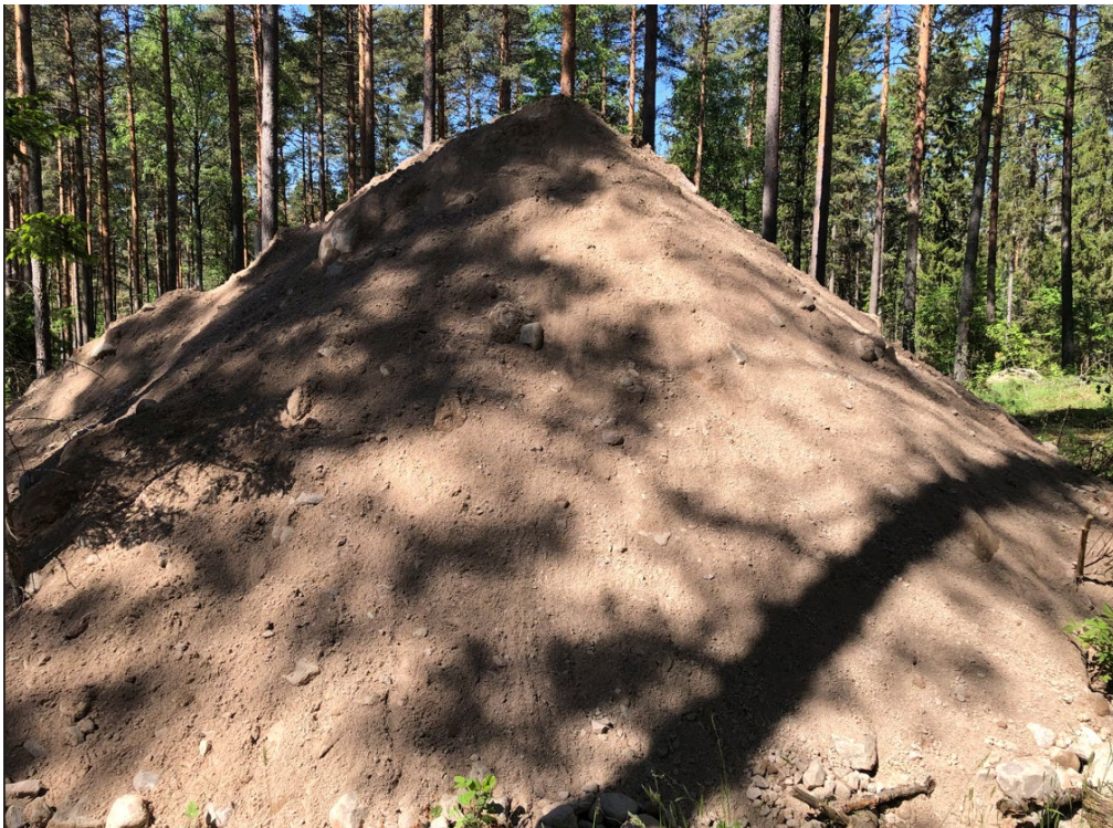
Schaktmassorna från SK14
