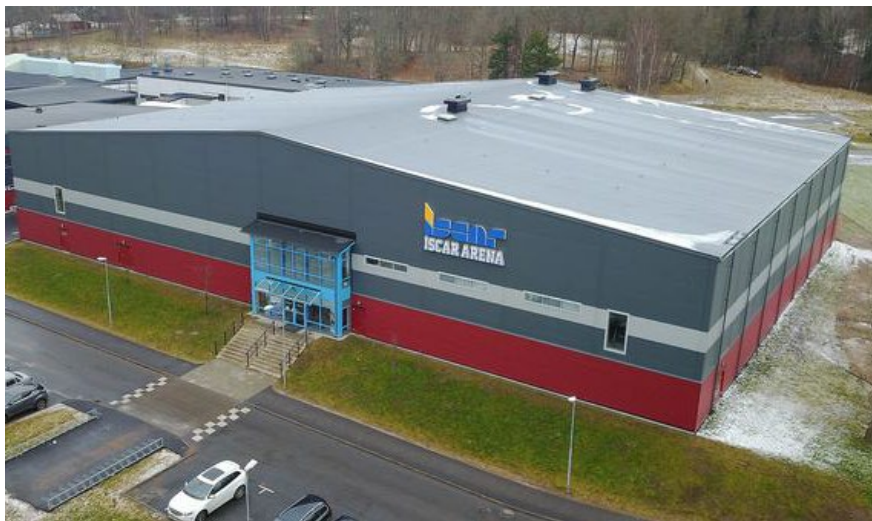
Figur 20: Flygfoto över befintlig sporthall "Hasset's sportcenter"
