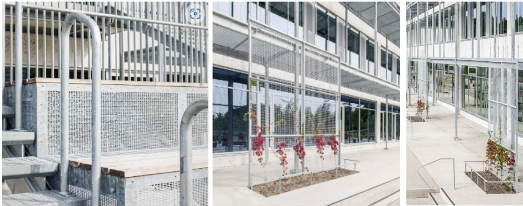
Figur 14: Inspirationsbild som visar hur gradängerna med sittplatser runt scenen kan utformas med hjälp av robusta material som t.ex. förzinkade / aluminiumraster. Liknande raster/ställning kan användas för klättrande växter som bryter ned den långa fasaden, gör att byggnaden smälter in i naturmiljön samtidigt som den utgör ett solskydd för utemiljön i södra läget. Bildkällan: Tengbom, Fornuddens skolan, Tyresö
