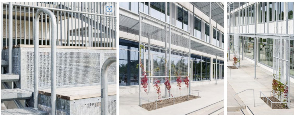
Figur 12: Inspirationsbild som visar hur gradängerna med sittplatser runt scenen kan utformas med hjälp av robusta material som t.ex. förzinkade / aluminiumraster. Liknande raster/ställning kan användas för klättrande växter som bryter ned den långa fasaden, gör att byggnaden smälter in i naturmiljön samtidigt som den utgör ett solskydd för utemiljön i södra läget. Bildkällan: Tengbom, Fornuddens skolan, Tyresö
